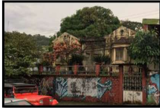
Estado Actual del predio en 2018
